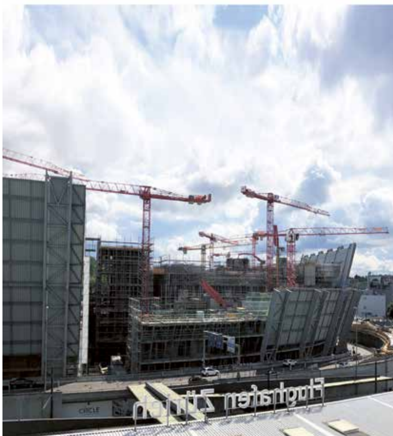
Die Baustelle verschwindet hinter der Schutzwand. Foto: Philipp Bircher
