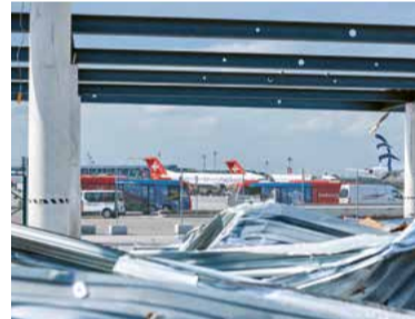
Baustelle mit Blick auf Flugverkehr.
