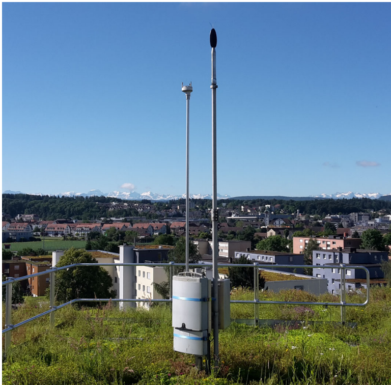
Abbildung: Messanlage mit Mikrofon, Wettersensor und Schallanalysator im Schaltschrank
